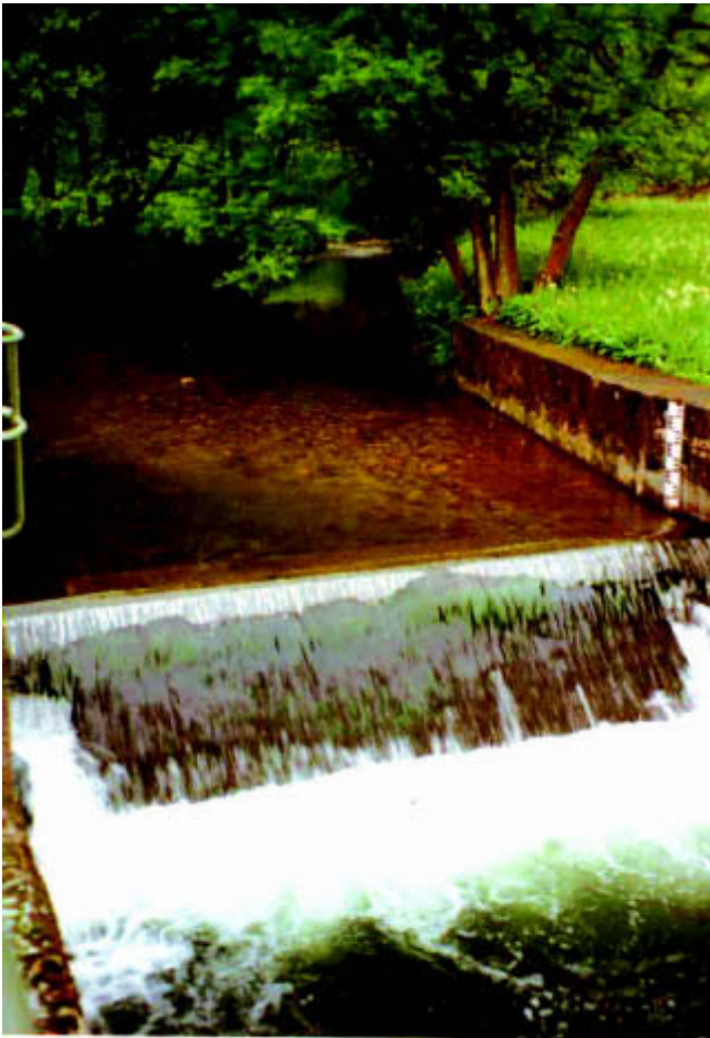
Abb. 3.2.4.2: Ein Absturzbauwerk an der Neger – Wassergüte gut, Strukturgüte schlecht
